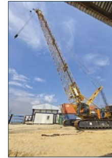
200 Ton Crawler Crane
